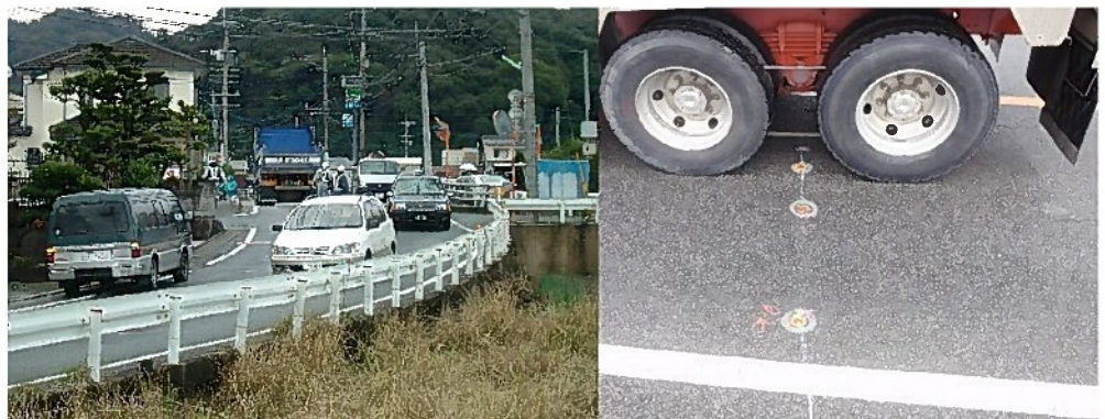
載荷試験調査の状況（1）
