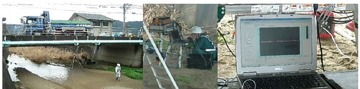
載荷試験調査の状況（2）
