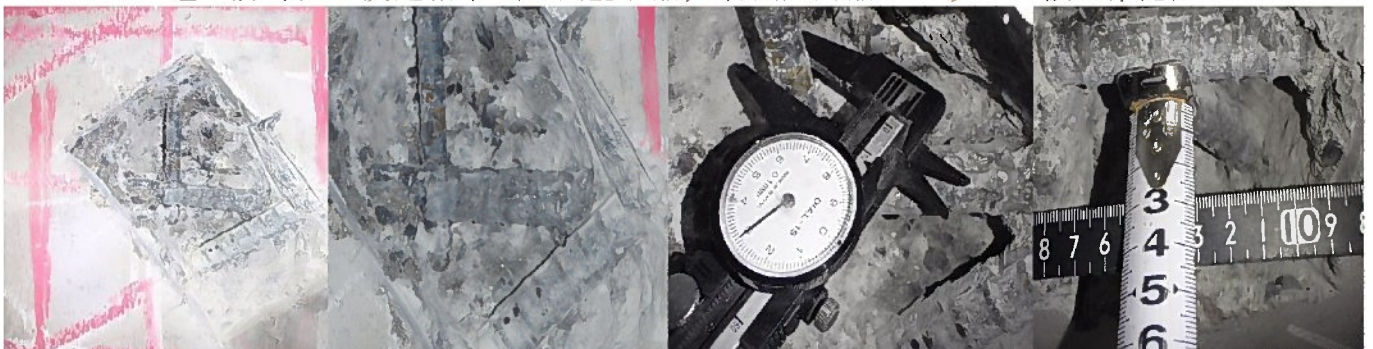
電磁誘導法にて位置確認→ はつり調査（腐食状況・鉄筋径・被り確認）
