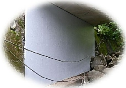
施工後(炭素繊維被覆)
