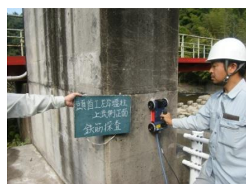
鉄筋探査(RCレーダー)
