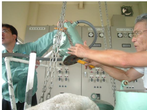
満水検知器撤去状況
