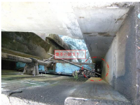
一次診断結果（土砂吐水門 No. 1）
