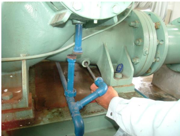
ドレン管撤去状況
