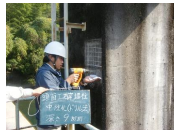
中性化試験(ドリル法)
