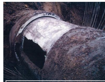
PC管変状調査
