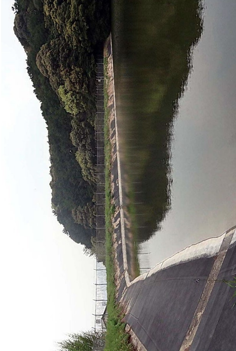
西区の西山池のり面を試験的に 導入された防墜型ブロック。階段状 になっており、指をかける溝もある
